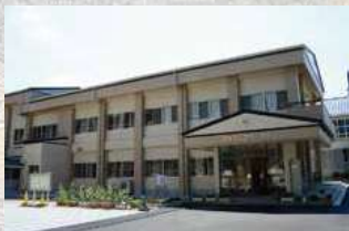
加美小学校大規模改修工事開始
