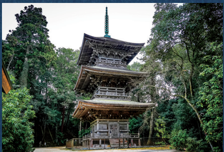
本山寺（本堂・三重塔）
